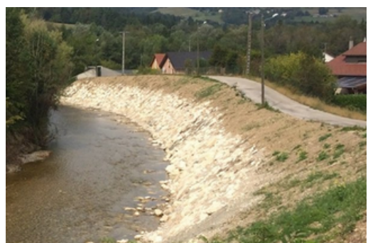
Digue de la Broue à Entre-Deux-Guiers
