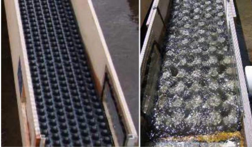
Rampes équipées de dispositifs de type « plots à anguilles » et « plots evergreen », pour favoriser le franchissement par les lamproies (source : Besson et al., 2009)
